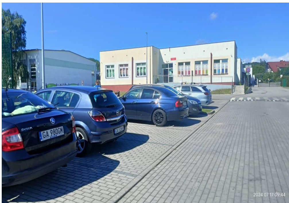
Fot. 16. Parking z nawierzchni nieprzepuszczalnej przy Zespole Szkolno-Przedszkolnym nr 2 (fot. Natalia Horak)
