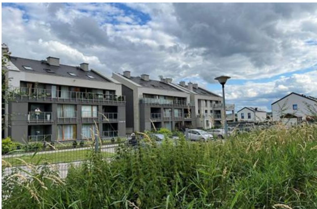
Fot. 9. Wielorodzinna zabudowa mieszkaniowa na osiedlu Rekowo Dolne przy ul. Polnej (fot. Małgorzata Bidłasik)
