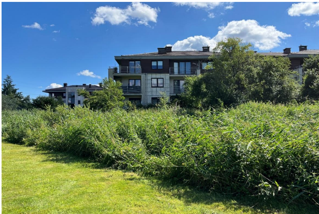
Fot. 36. Zabudowa miejska w okolicy Miejskiego Parku Rodzinnego przy ulicy Olimpijskiej z uszczelnionym parkingiem od strony koryta rzeki (fot. Małgorzata Bidłasik)
