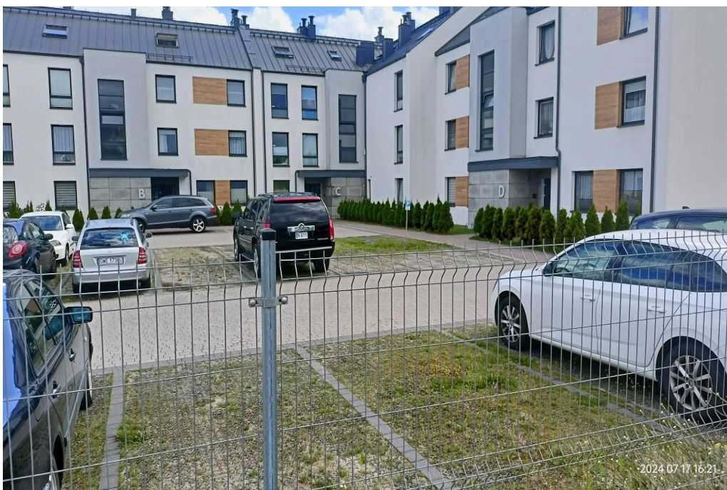
Fot. 18. Dobry przykład miejsc parkingowych z przepuszczalną nawierzchnią z geokraty na osiedlu przy ul. 12 Marca (fot. Natalia Horak)
