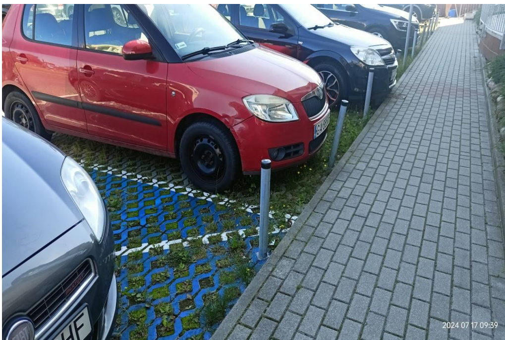
Fot. 17. Parking z nawierzchnią z betonu ażurowego w pobliżu ul. Osadniczej (fot. Natalia Horak)
