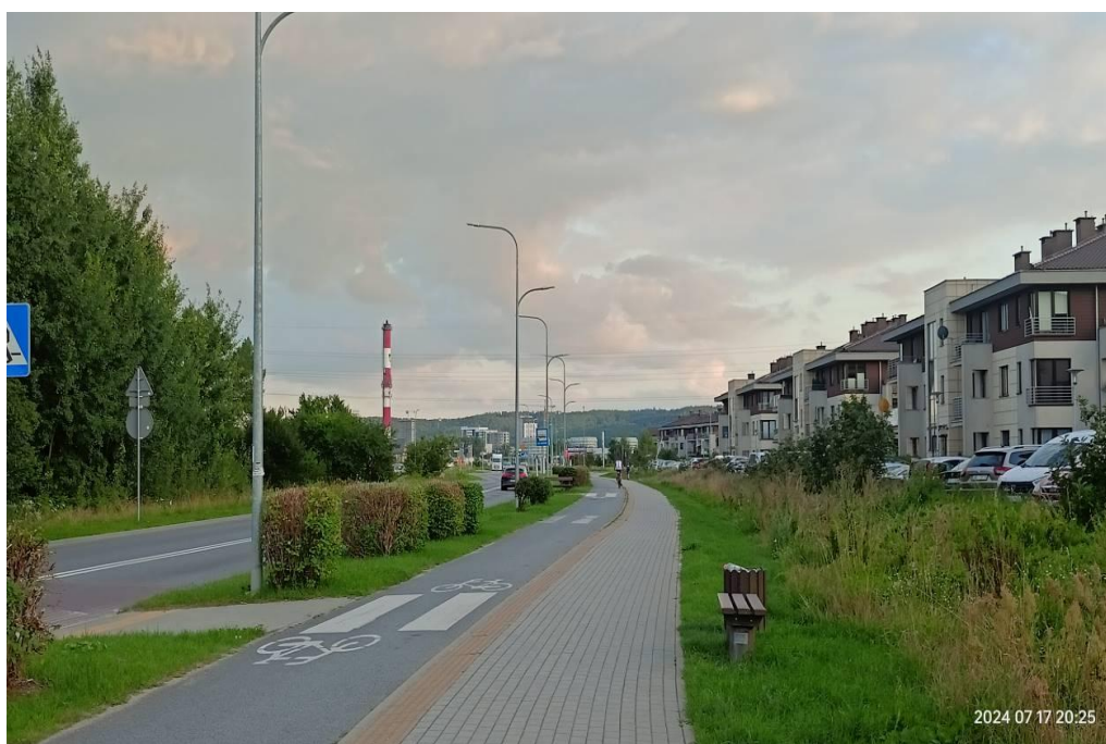
Fot. 23. Ścieżki rowerowe i chodnik dla pieszych oddzielone od jezdni buforem zieleni, biegnące wzdłuż rowu infiltracyjnego, na ul. Obwodowej (fot. Natalia Horak)
