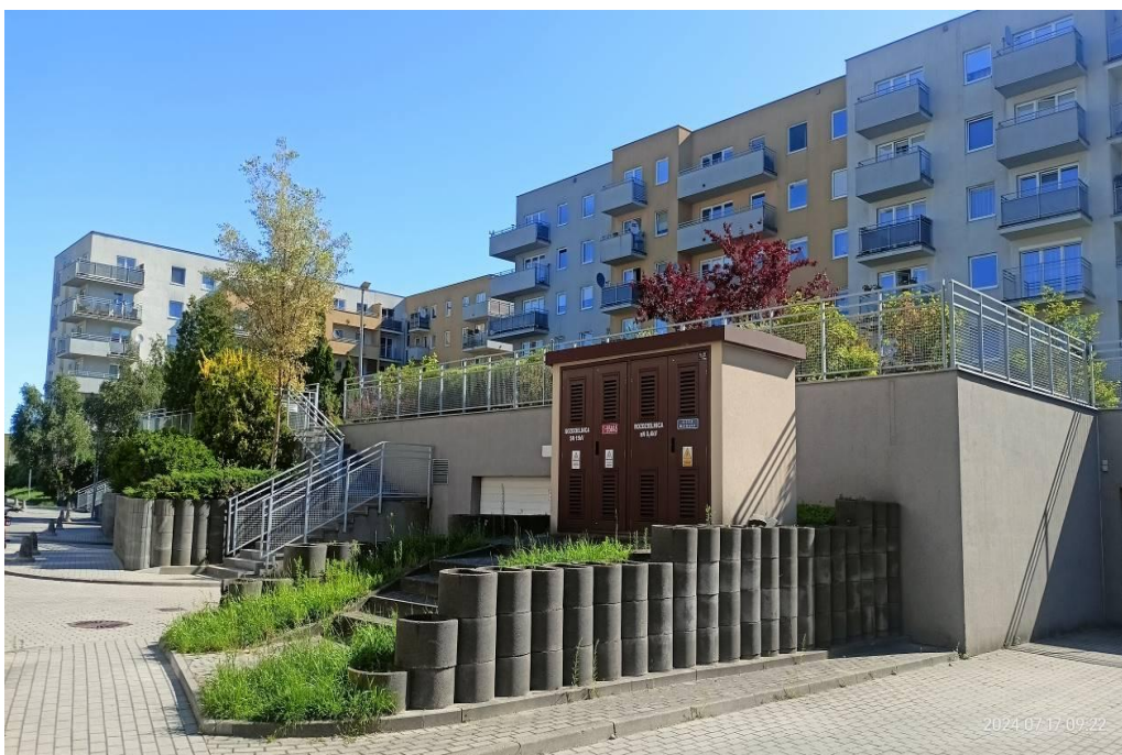
Fot. 20. Dobry przykład zagospodarowania zielenią dachu garażu przy ul. Osadniczej (fot. Natalia Horak)
