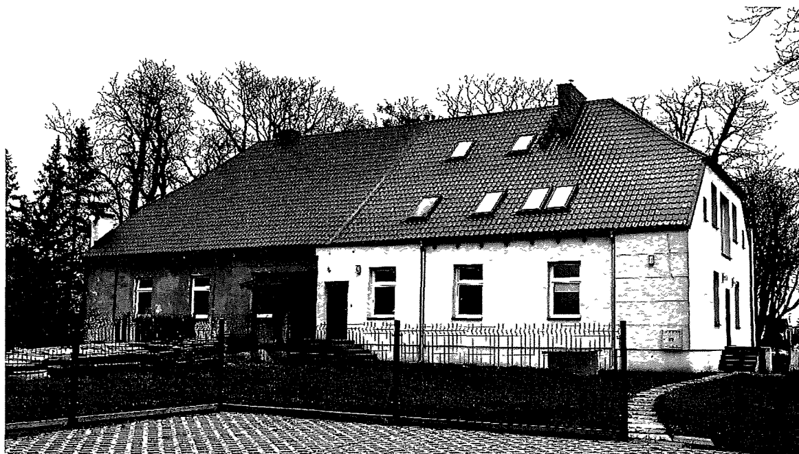
Fot. 2. Reda-Ciechocino. Budynek dawnego dworu, ul. Gajowa 9 (fot. autor opracowania).
